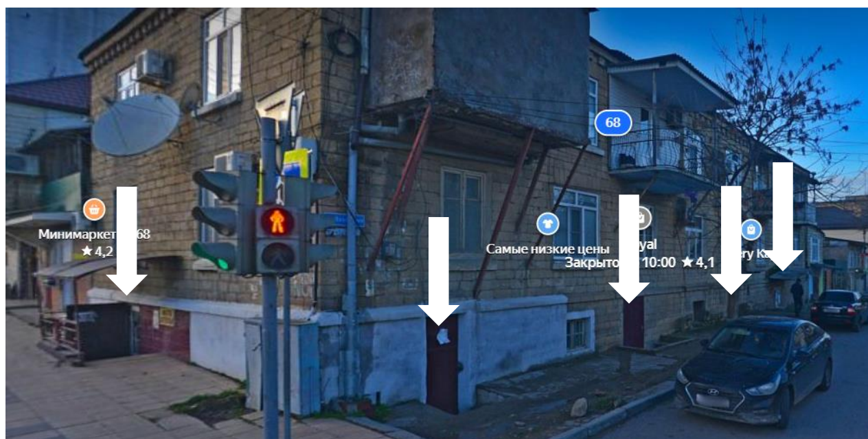
Множественные входы в подвальные помещения снесенного здания по ул. Буйнакского, 68
